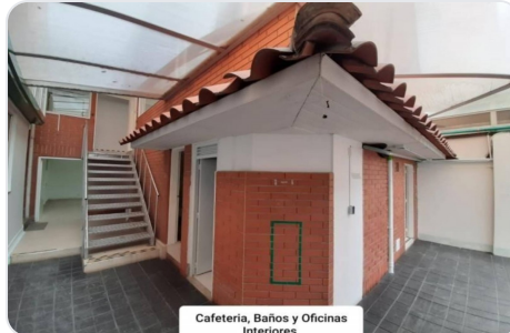
Cafeteria, Baños y Oficinas Interiores
